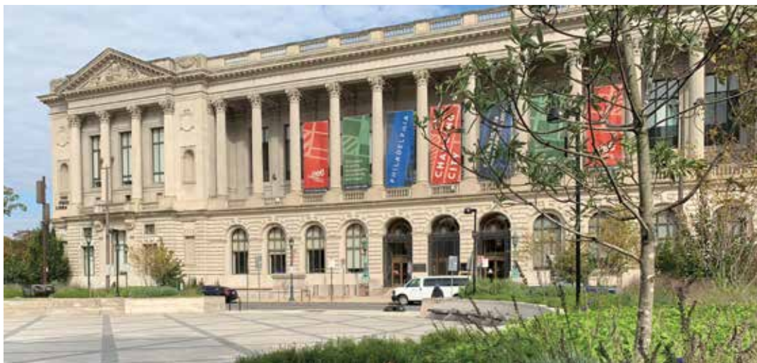
Toiture et terrasse végétalisées, Philadelphie, PA
