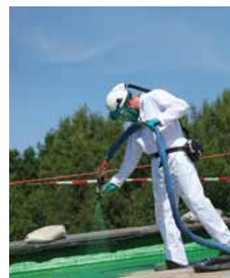
Installation d'une membrane Prodeq FX400
