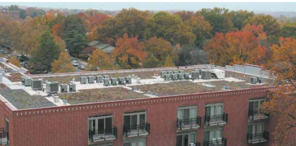
Toiture végétalisée, Falls Church, VA
